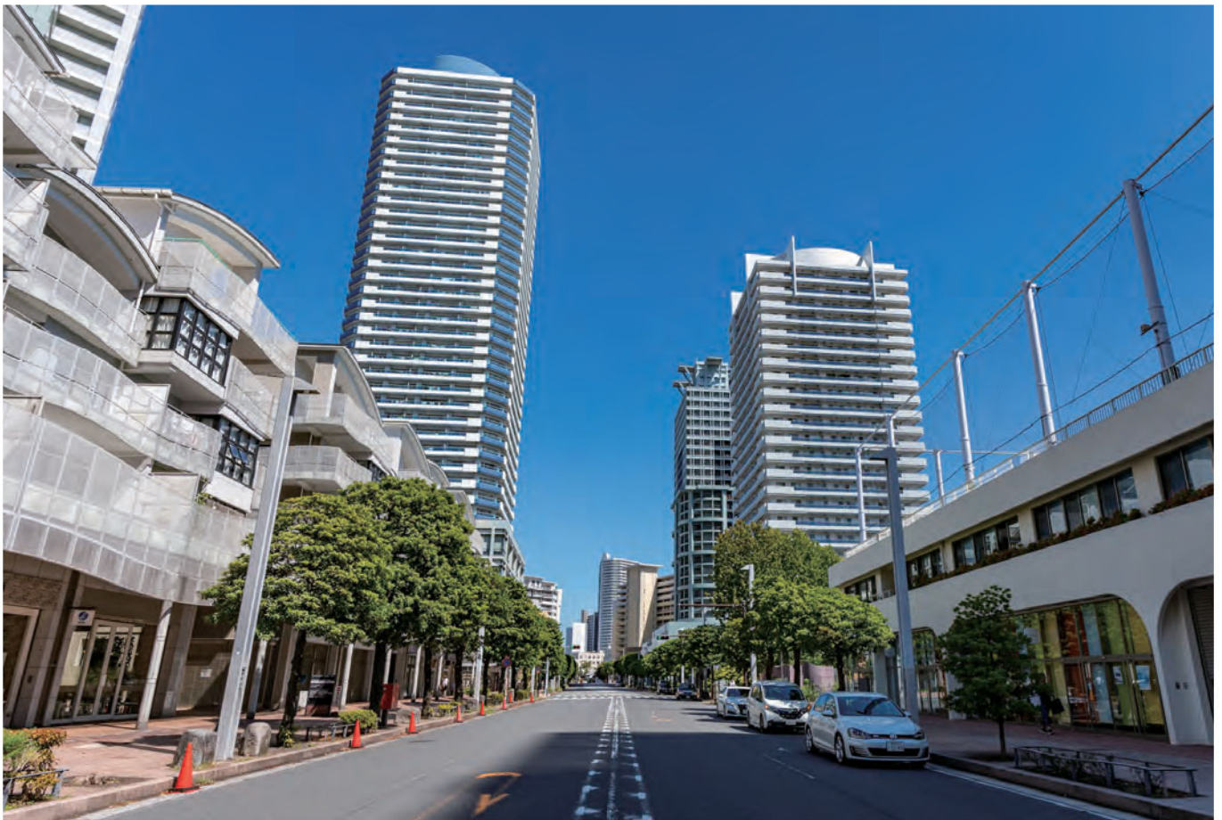
▲ CABシステムにより無電柱化となったギャラリーロード
